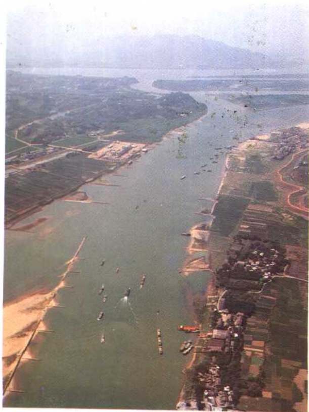
建设中的广州至南宁千吨级航道的东平水道。（黎家添 摄）
