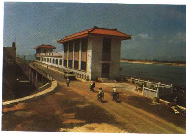
北江芦苞水闸。左侧为1924年建成的旧闸，右侧为1987年建成的新闻。（胡璟 摄）
