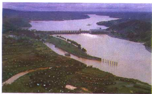
西江支流郁江上的西津水电站和船闸。（张长江 摄）
