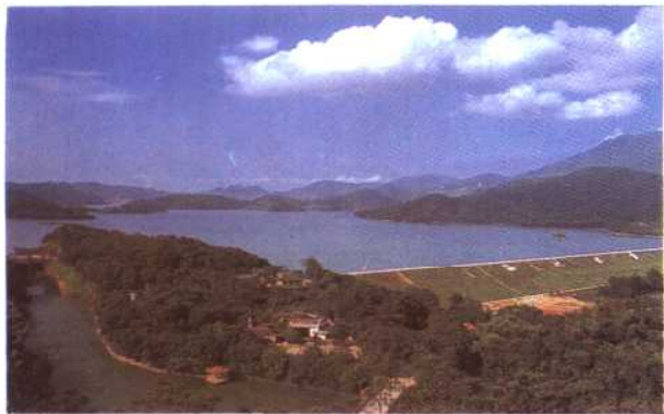
对香港供水的深圳水库。
