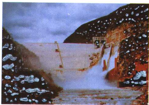
南盘江支流黄泥河上的鲁布革水电站。
