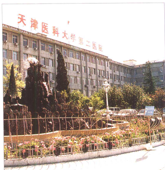
25 门诊部前广场假山水池景观(天津医科大学第二医院)
