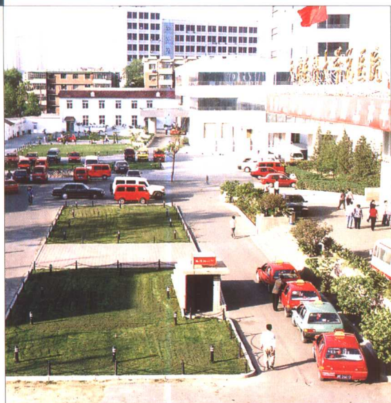
21 建筑前广场兼作停车场(天津市医科大学总医院)
