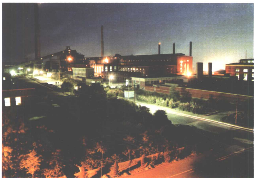
白银公司冶炼厂生产现场一角
