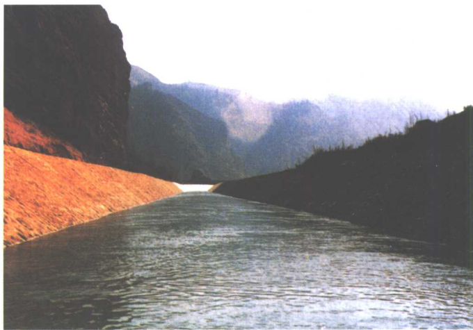
引大入秦工程输水干渠
