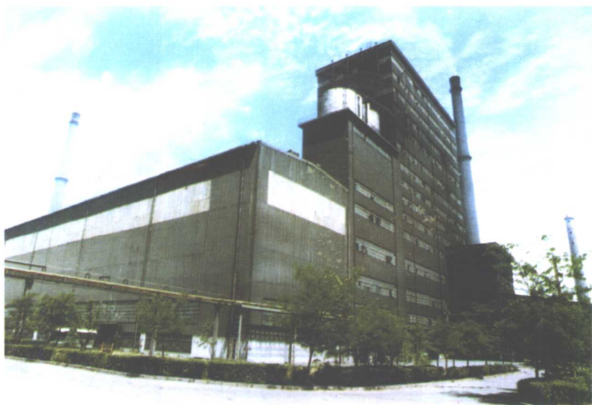
镍都金川被称为亚洲第一炉的金川公司二期镍闪速炉
