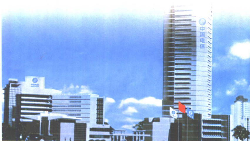
建设中的兰州第二电信枢纽
