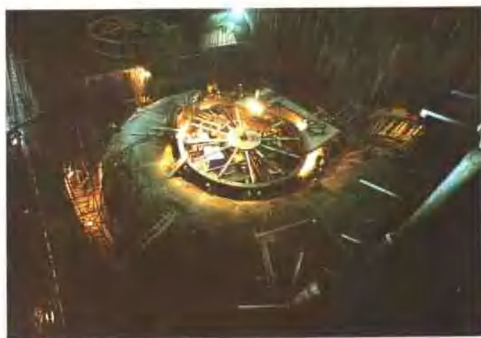
6号地下厂房蜗壳安装
