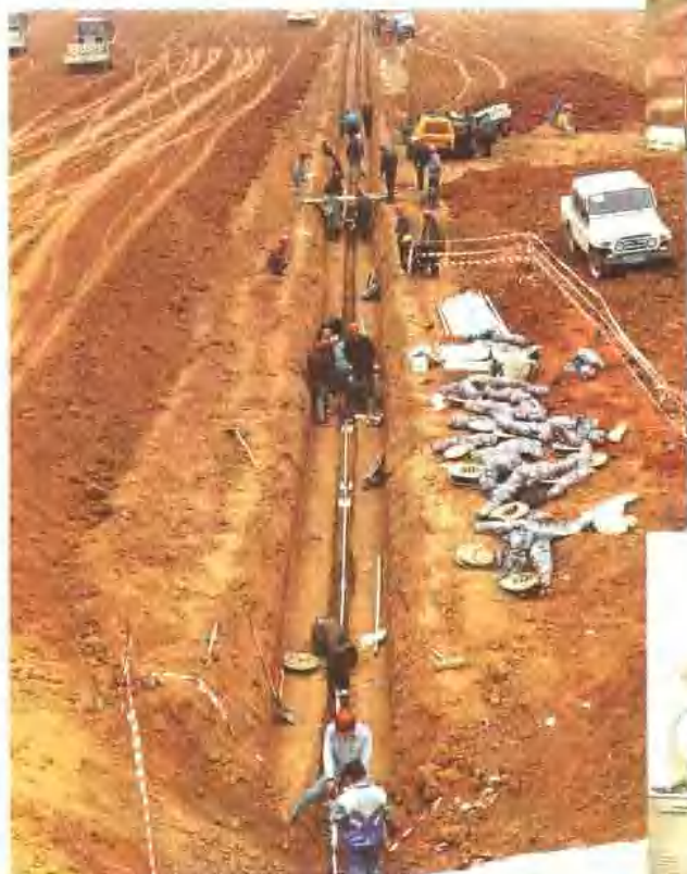
大坝原型观测仪器埋设
