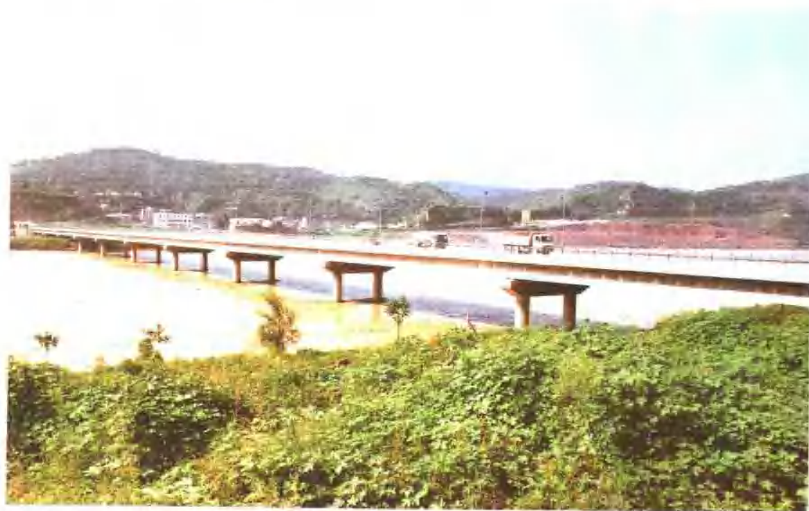
小浪底黄河公路大桥 (载重量 85t)
