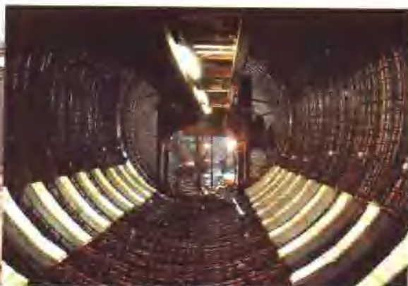
排沙洞预应力钢绞线安装 (衬砌后洞径 6.5m)
