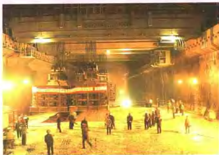
地下厂房 500t 桥吊荷载实验
