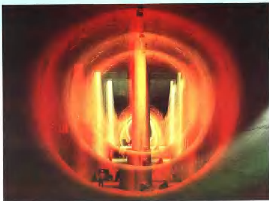
导流洞中闸室 (洞径 14.5m, 最大开挖洞径 19.5m)
