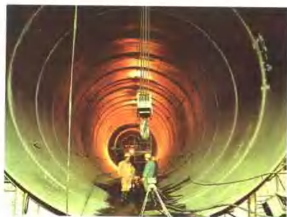
发电引水洞压力钢管安装 (内径 7.8m)
