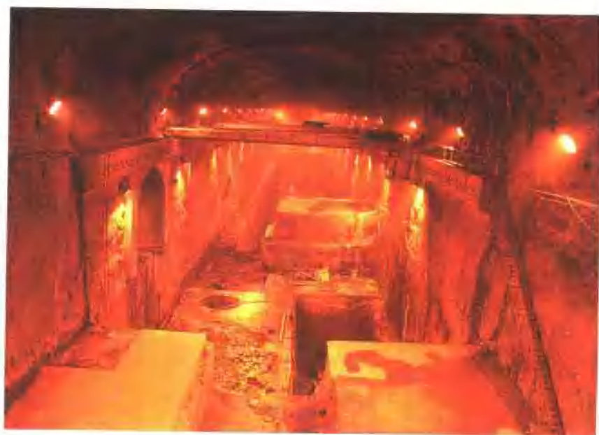
地下厂房开挖 (251.5 × 26.2 × 61.44m)
