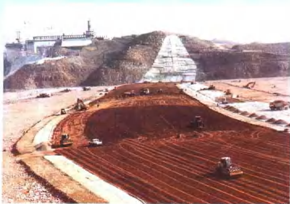
填土斜心墙堆石坝填筑
