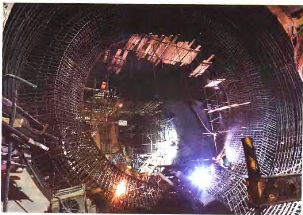
泄洪洞孔板环施工
