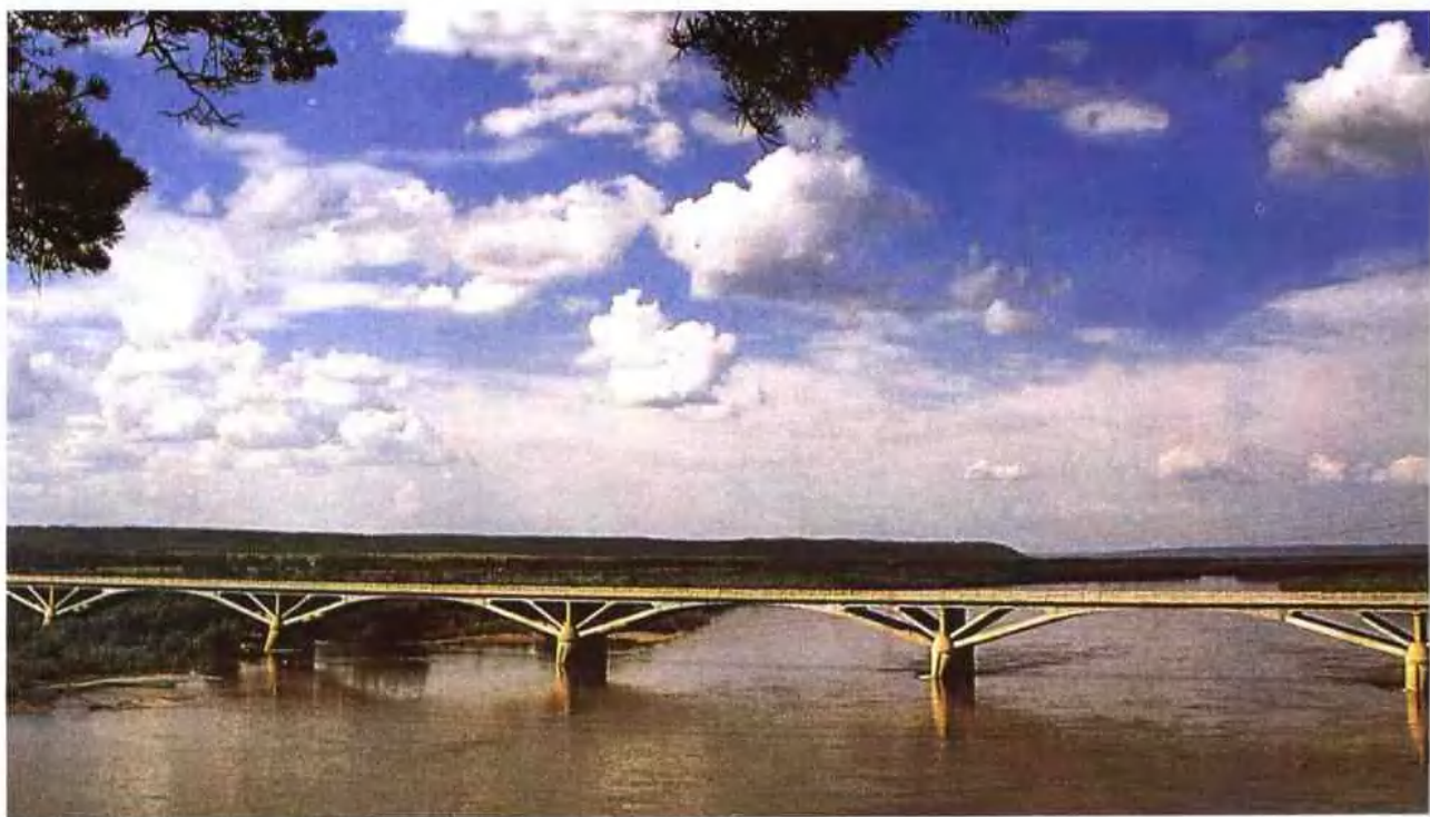
呼马河大桥（刚架拱）
