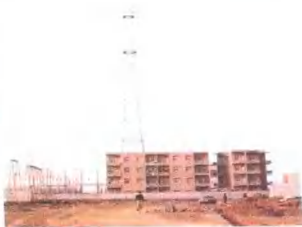
220千伏输变电站
