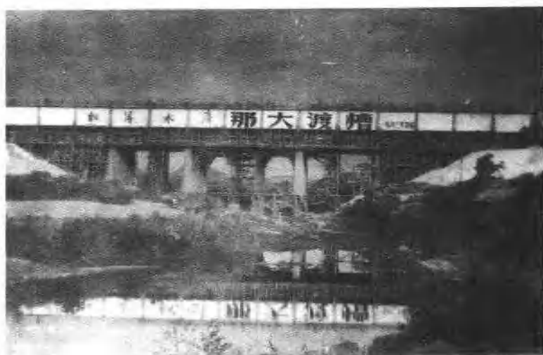
松涛灌区流量最大的那大渡槽
