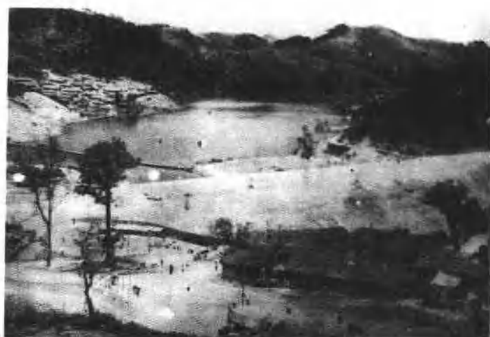
大坝前堤 170 米拦洪断面完成。
