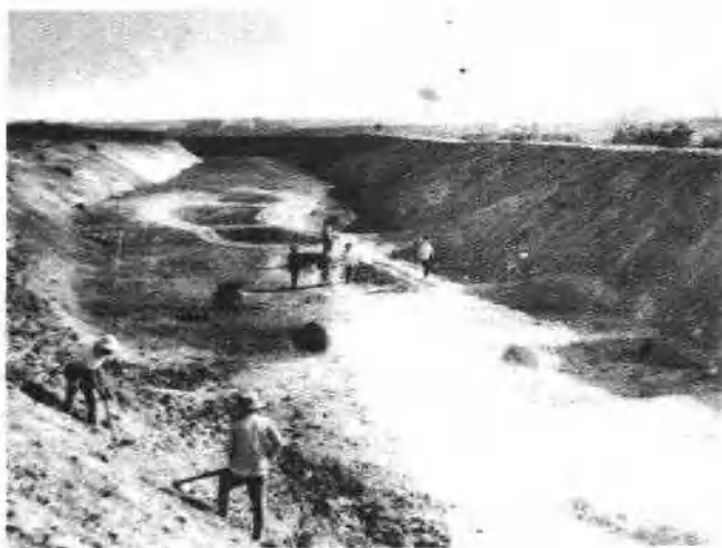
即将完工的松涛东干渠
