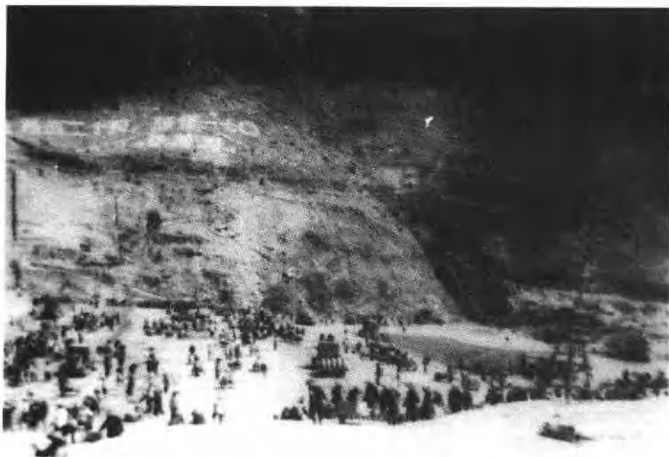
大坝填筑场面，拖拉机带肋形碾碾压。
