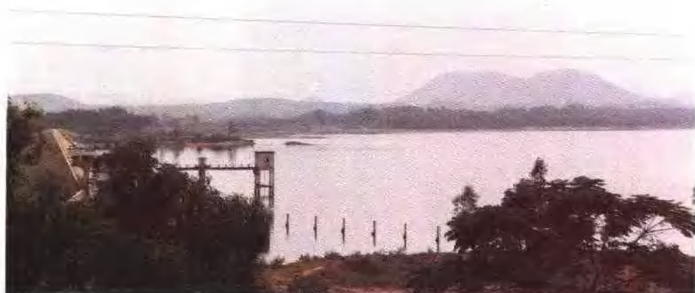
东干渠反调节水库之一——跃进水库
