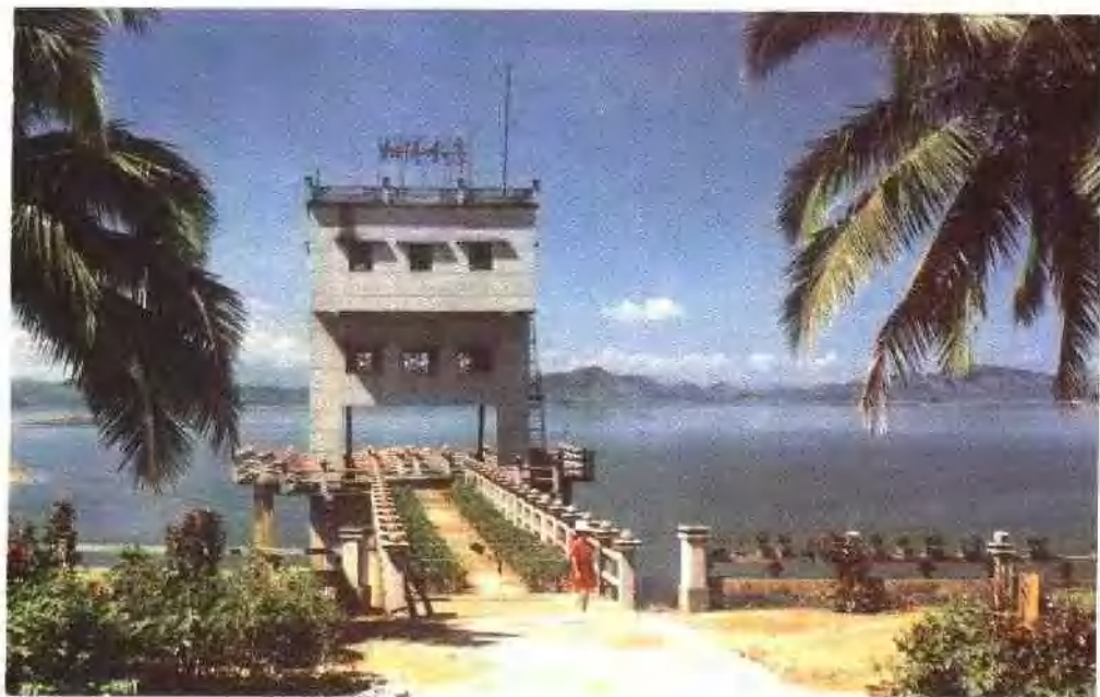
南丰输水隧洞进水塔
