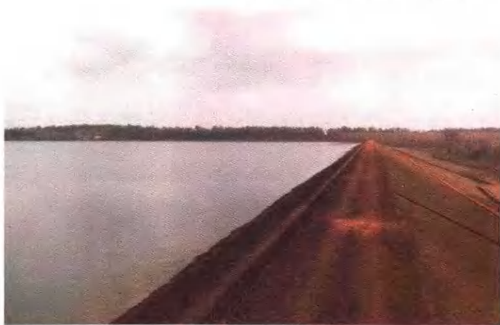
东干渠反调节水库之二——福山水库
