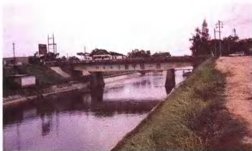
东干渠及公路桥
