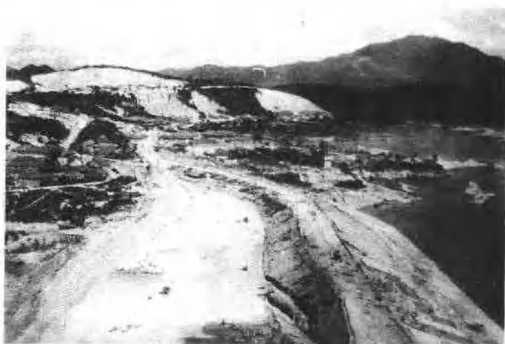
大坝前堤 185 米拦洪断面完成。
