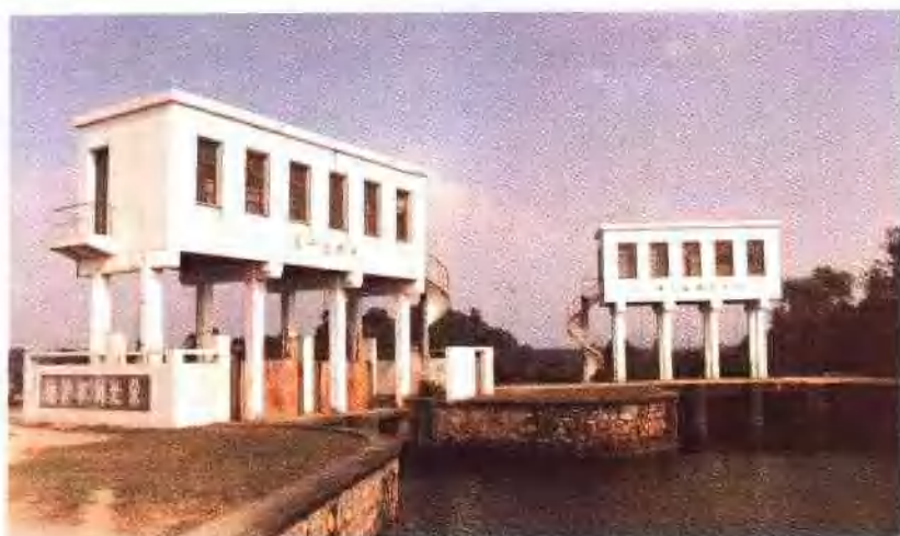
东干渠节制闸及那 大分干渠进水闸
