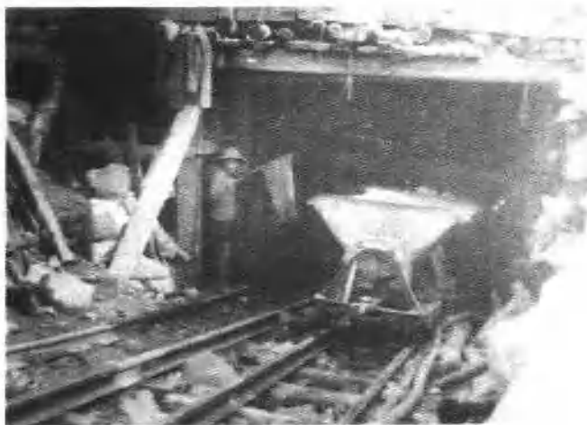
正在开挖中的南丰隧洞
