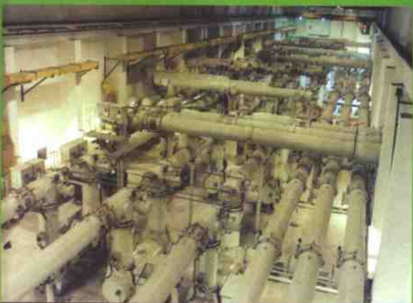
● ZF6-500 型六氟化硫封闭式组合电器
