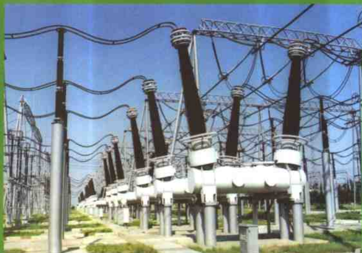
● LW12-500 型六氟化硫罐式断路器
