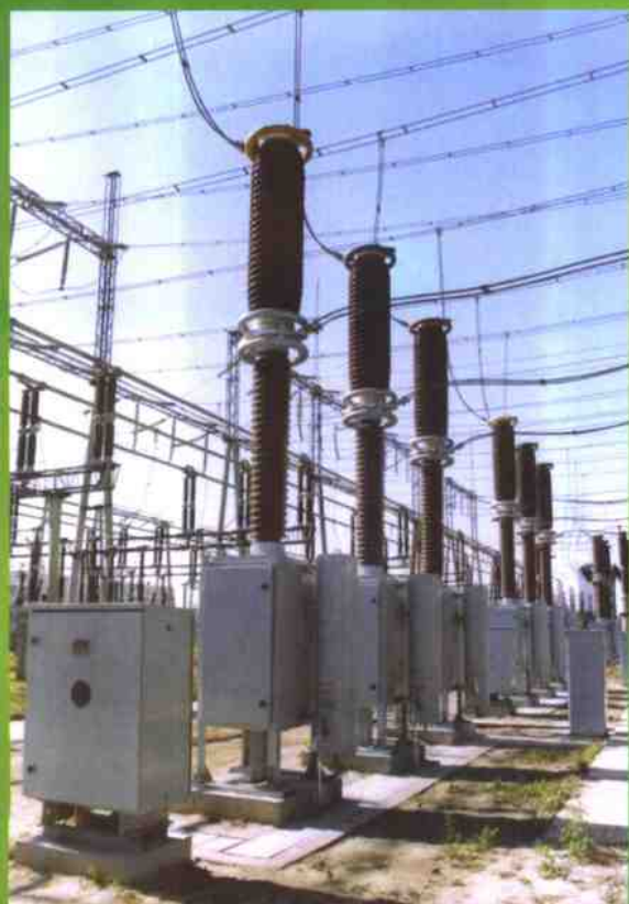
● LW11-220 型六氟化硫瓷瓶式断路器
