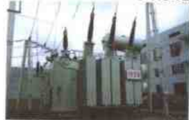
S8型10000-63000/110电力变压器
