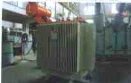
H级绝缘赛格迈(SECURAMID)干式配电变压器 SCR8-50-2000/10
