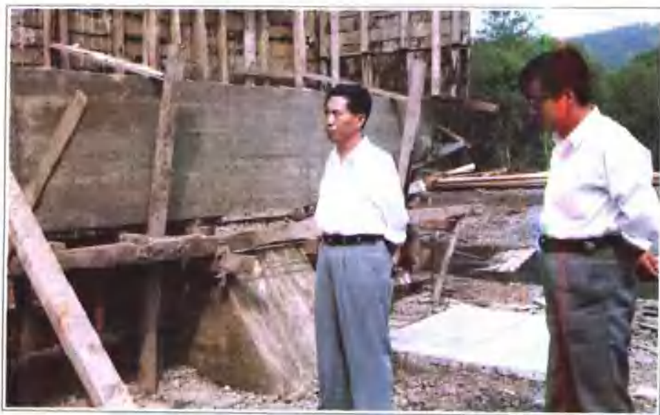
交通局局长 陈才(左) 塔溪乡党委书记 王惠臣(右)在塔溪桥施工现场
