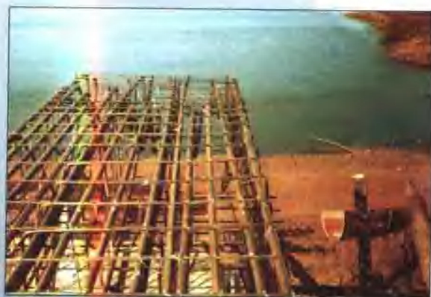
施工中的科后大桥
