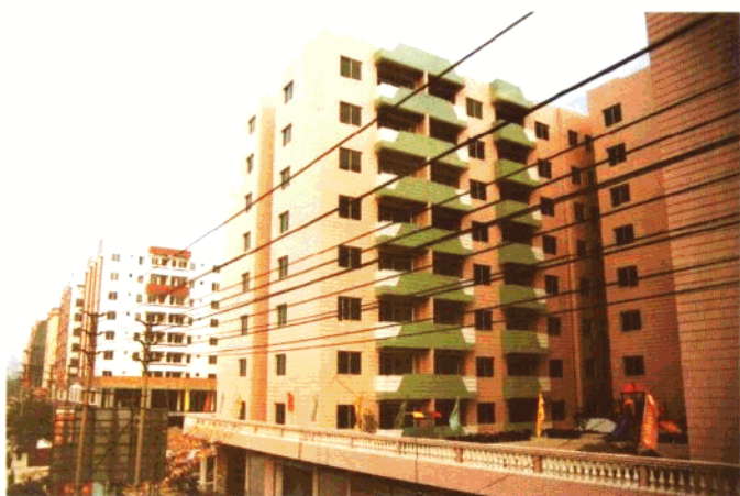
建设中的大小涡住宅区。
