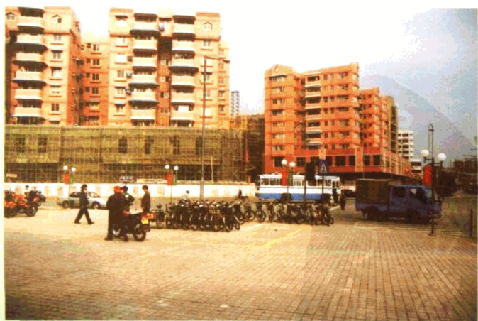
建设中的花地湾红棉苑北区商住区。
