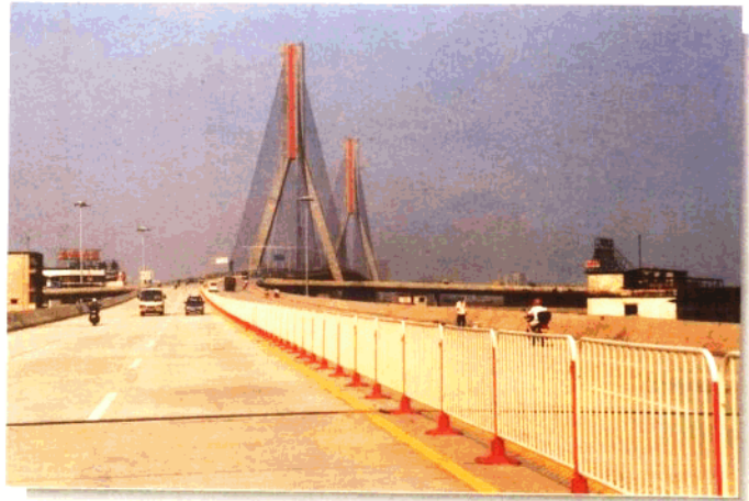
鹤洞大桥(1998年7月 23日建成通车)。
