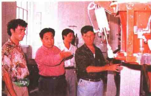
恒丰集团引进的第二条日处理300T小麦的意大利奥克利姆公司生产的等级粉生产线于一九九三年八月初安装完毕。图为赵永恒和两位意大利安装师在现场查看安装情况。
