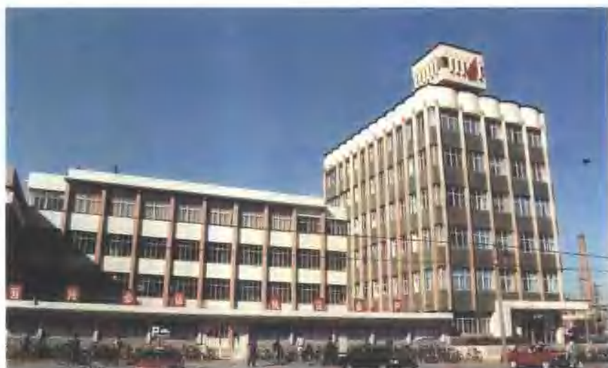
新建的银川市中级人民法院办公楼
