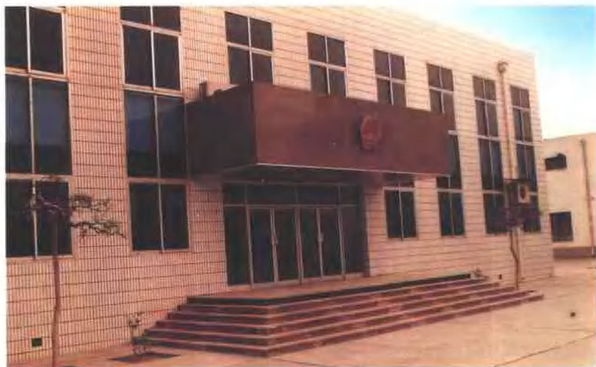
自治区高级人民法院审判厅外景
