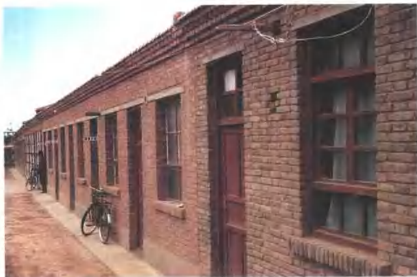
同心县人民法院旧址
