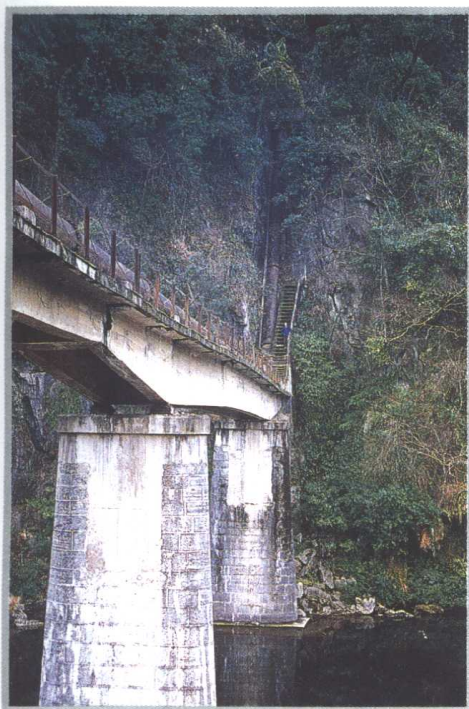
白水洞倒虹吸管工程
