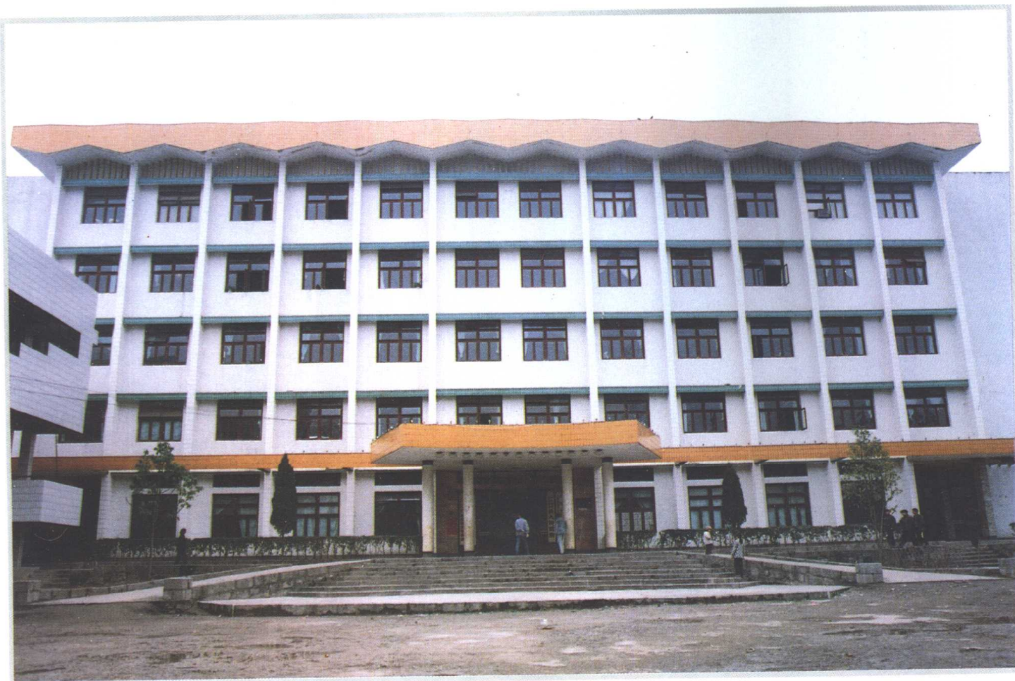
江口县委县政府办公楼
