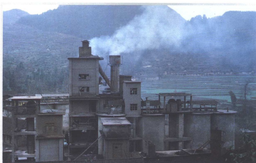
县水泥厂厂房
