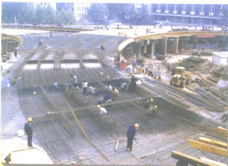
紫荆山立交桥施工现场
