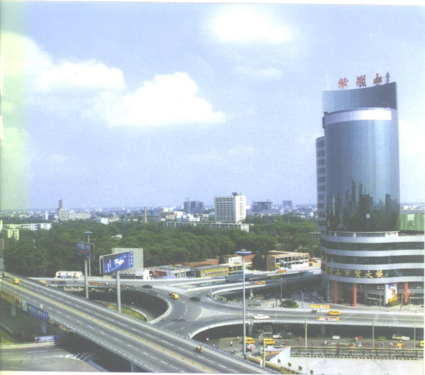
紫荆山立交桥
