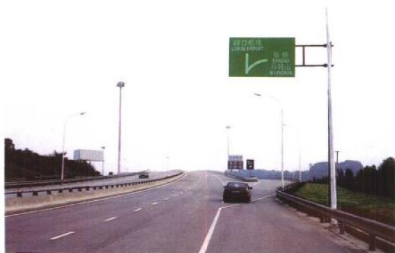
高速公路分叉口指示牌
