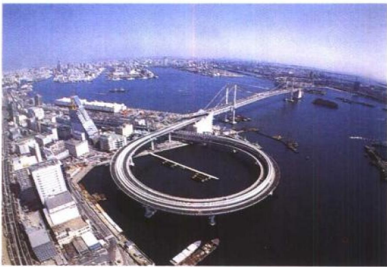
高架过海大桥
