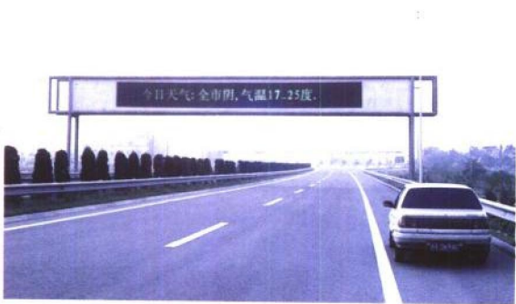
高速公路交通状况及气候显示屏
