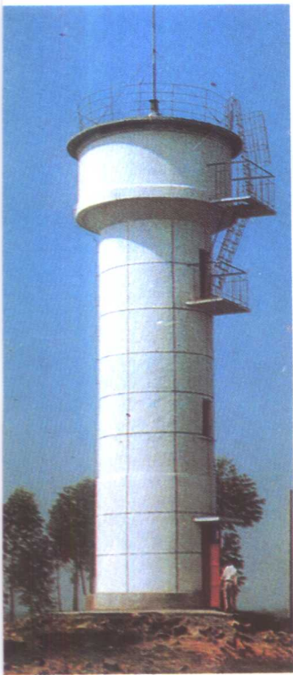
▲ 荣昌县古昌乡的自建 水塔
