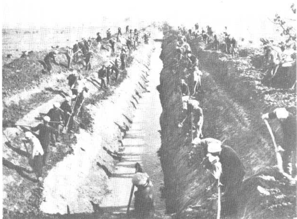
平原地区广大群众挖沟开渠，排涝治碱。
