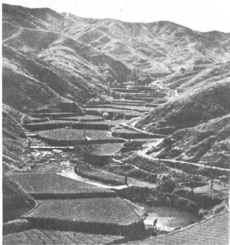
山区人民广修小塘坝， 拦洪蓄水。
