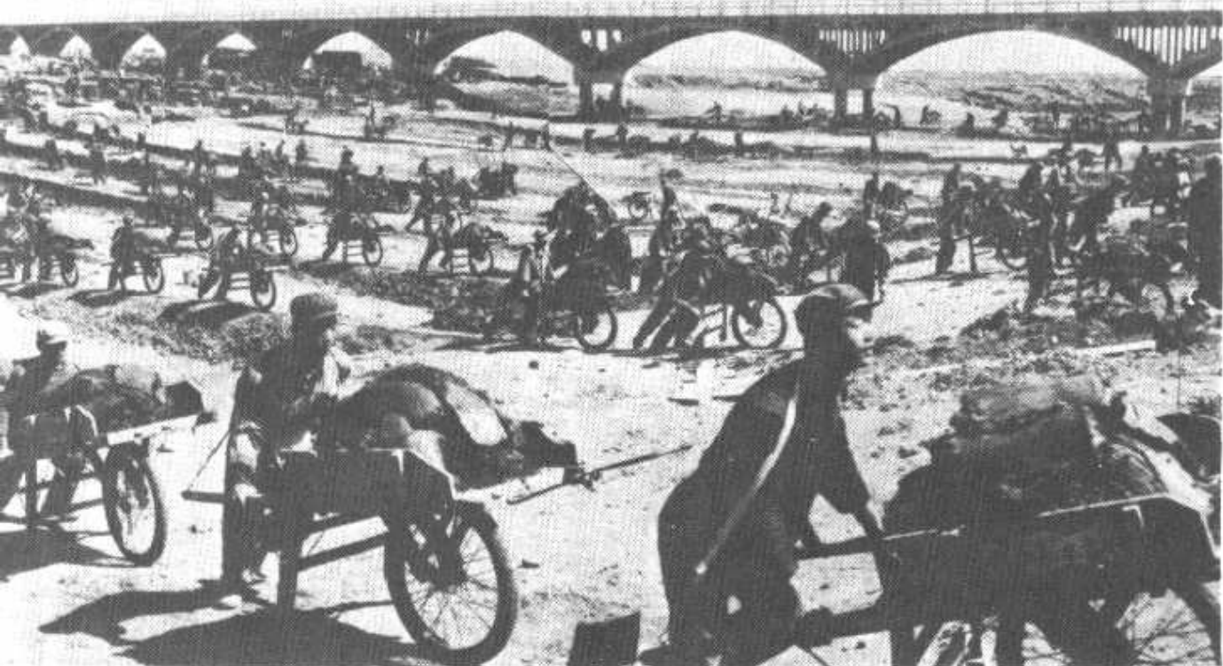
河未通,桥先成。这是采用井柱建桥法在蓟运河改道线路上建成的双曲拱大桥。
