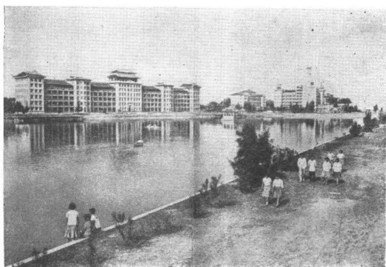
集美中学校舍之一——南薰楼(右)及道南楼(左)
