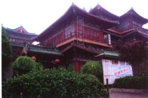
图一 新建的樊楼
