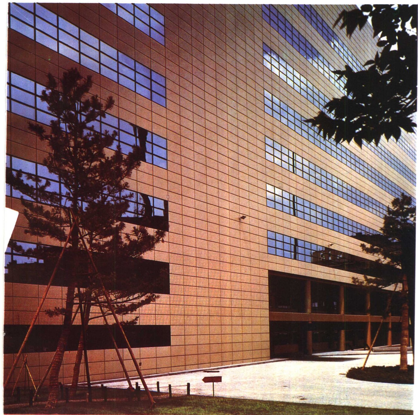
图3 东京美国大使馆（1972年设计） 统一方格网把混凝土及窗带处理成异常雅致的表面
