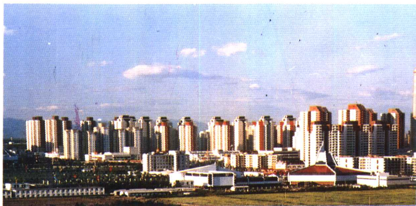
北京亚运村公寓一角
