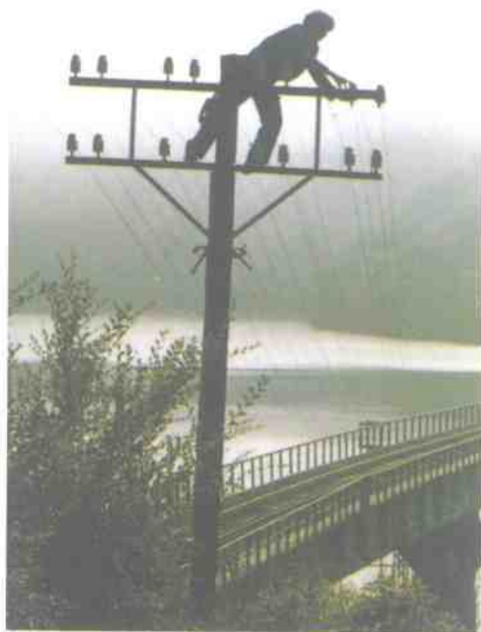
▲ 通信线路检修
