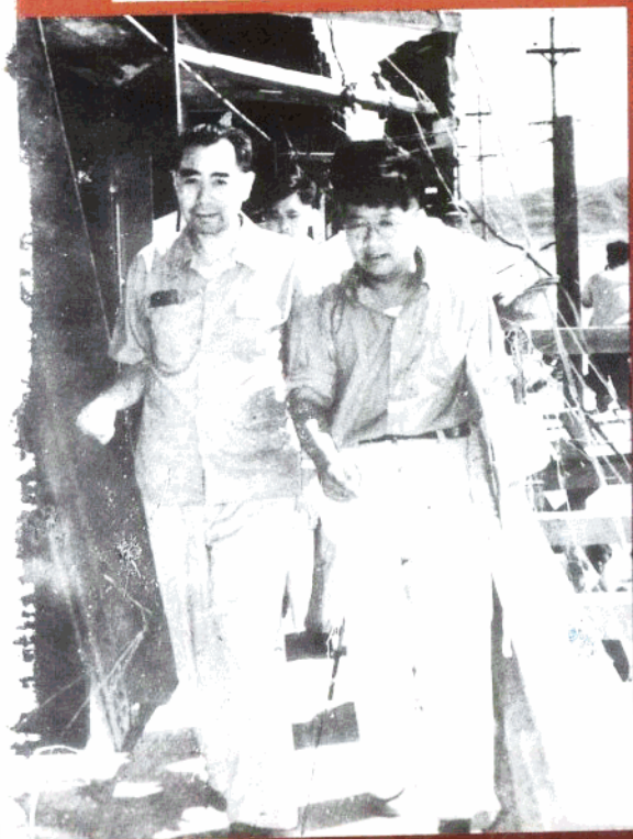
1958年周恩来总理现场指挥郑州黄河铁路大桥（旧铁路桥）抢险
