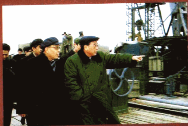
李鹏总理视察建设中的郑州黄河公路大桥
