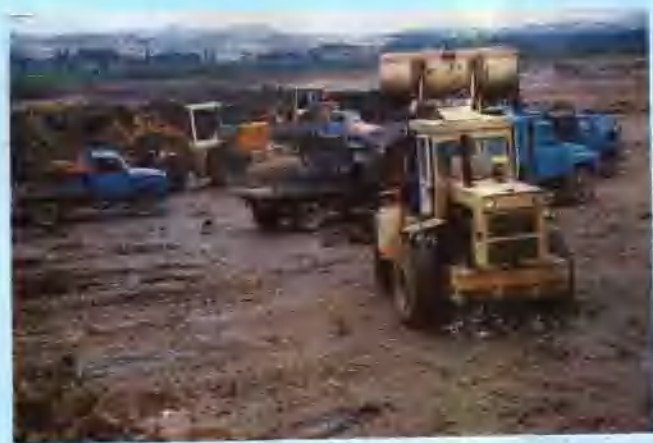
3. 机场建设进入决战阶段，突击抢运 10 多万立方米土方的场面。
