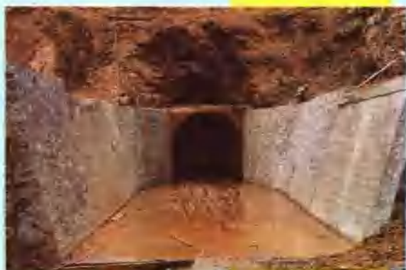
2、鱼洞水库导 流隧道出口。
