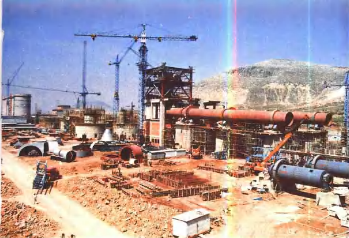
建设中的鲁南水泥厂 (枣庄市政府办公室供稿)
