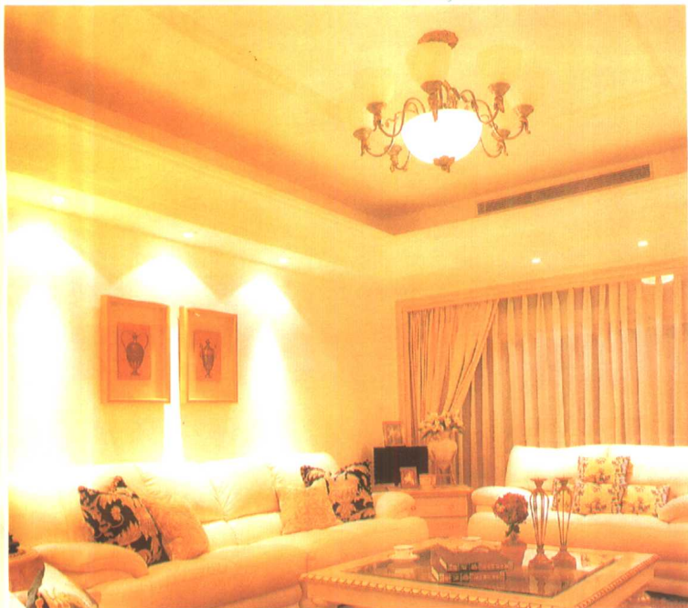
彩图 11 局部悬吊式顶棚
