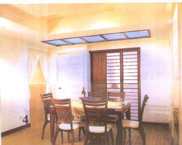
彩图 10 局部悬吊式顶棚
