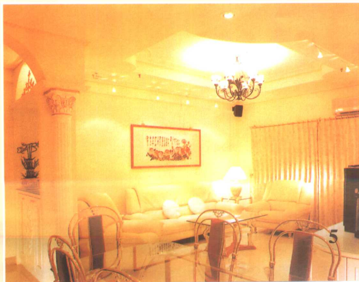
彩图 12 局部悬吊式顶棚
