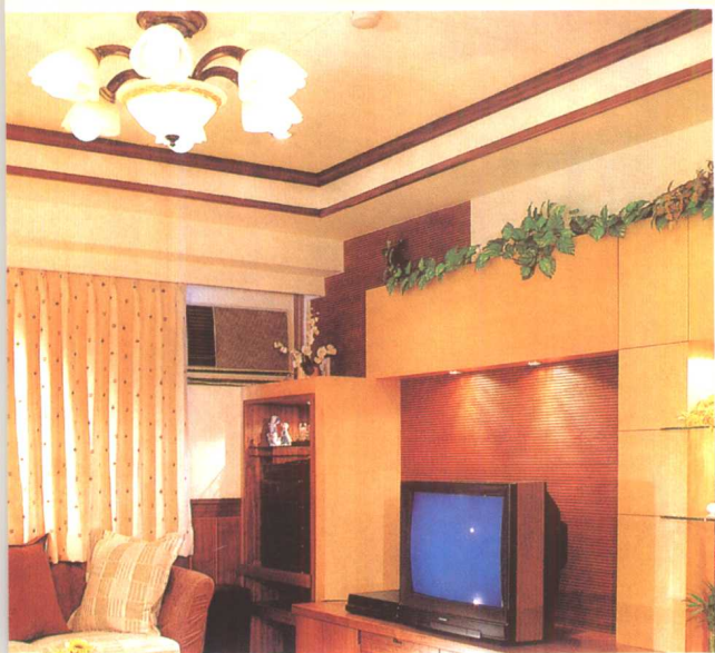
彩图 13 局部悬吊式顶棚
