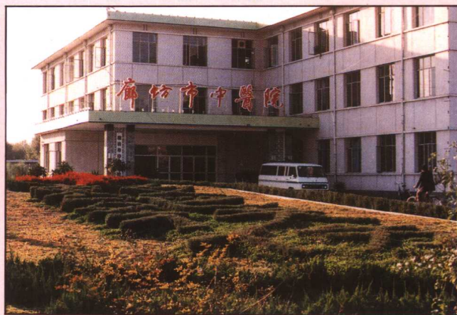
廊坊市中医院门诊楼
