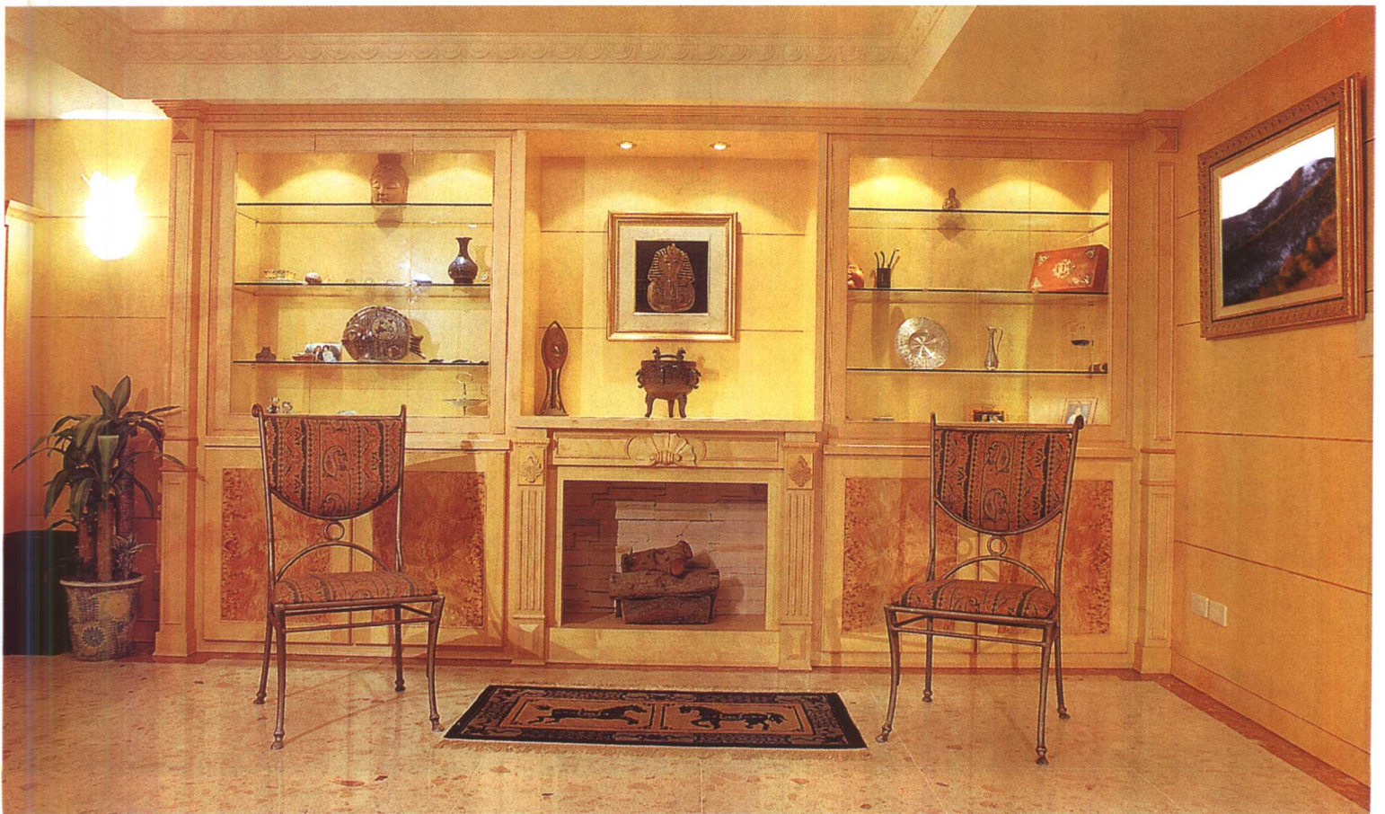
↓ 壁炉不但美观而且有实用性——利用电热管取暖，并以抗热文化石材作为壁炉围覆，成为典型的“现代无烟壁炉”。
