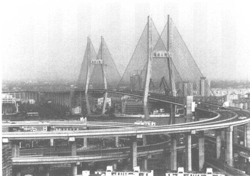
图 1-1-8 上海南浦大桥 上海南浦大桥为主跨 423m 斜拉桥。
