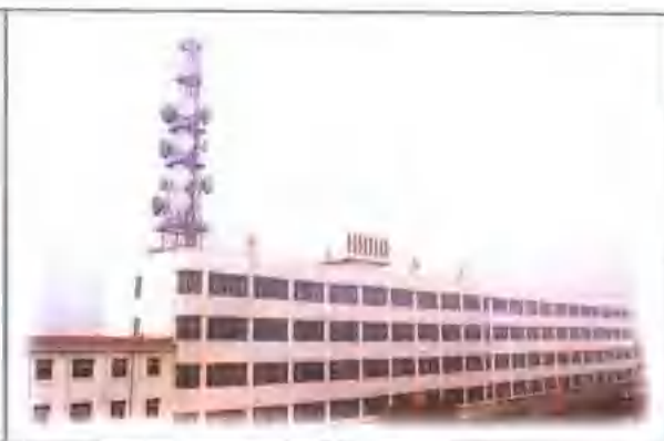
即将全面竣工的衡水刷电大楼
