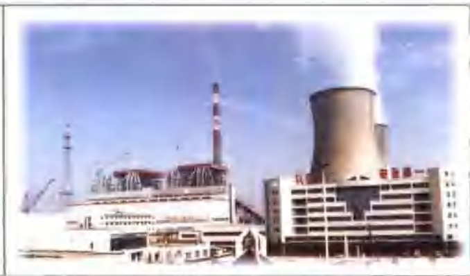
正在建设中的国家重点工程——衡水电站
