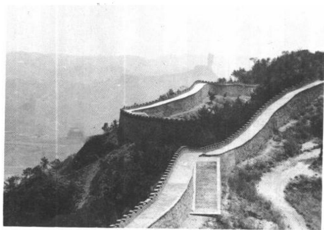
热河行宫山区东北面宫墙。该图为1979年修复宫垣后的摄影
