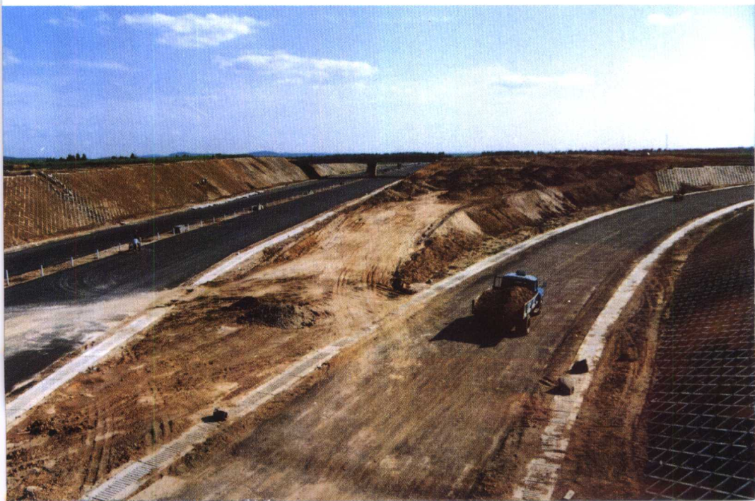
建设中的长春——四平高速公路 (李本东 摄)
