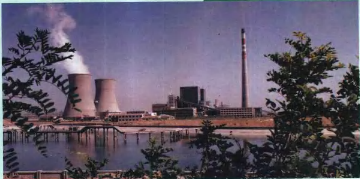
建设中的大坝发电厂
