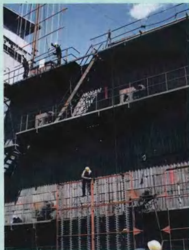
改造电除尘器
