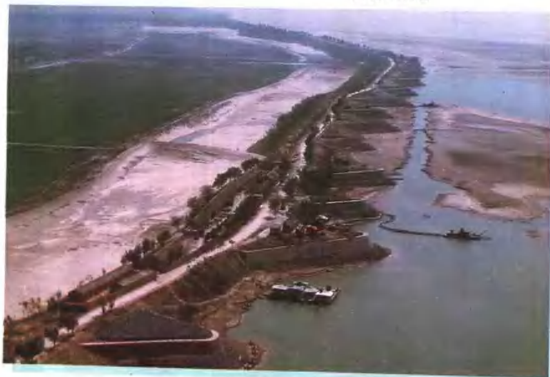
河南黄河曹岗险工 (此页均为殷鹤仙 摄)
