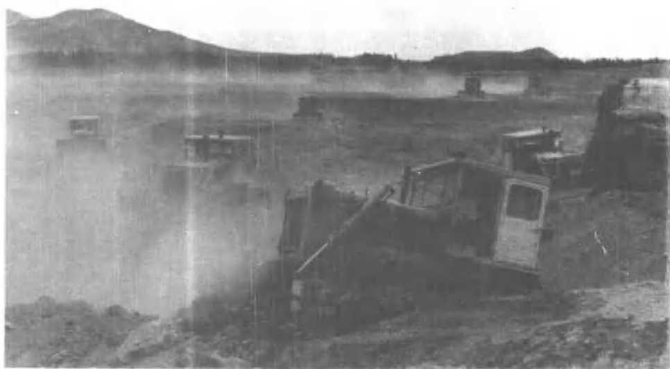
建团初期，机力开荒造田。这是开挖新建水库时的情景。
