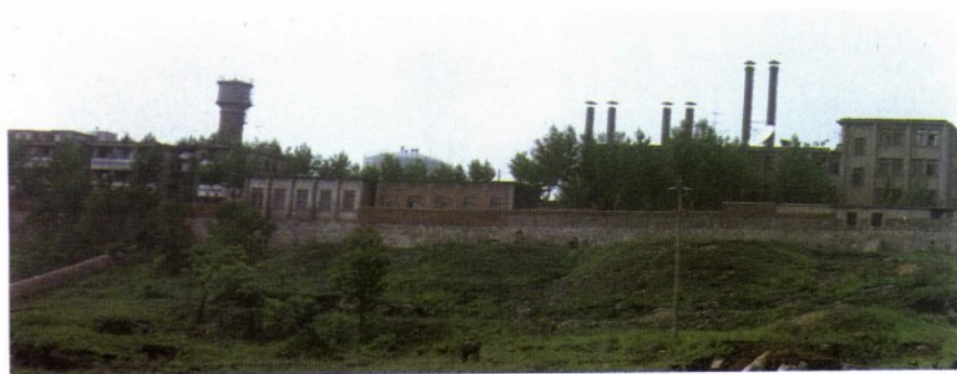
鲁宁输油管线盱眙泵站
