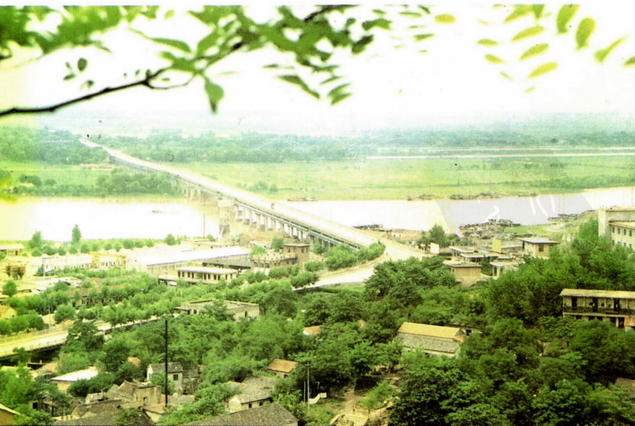
公路油管两用桥——淮河大桥
