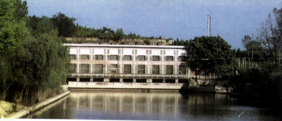
清水坝电灌站
