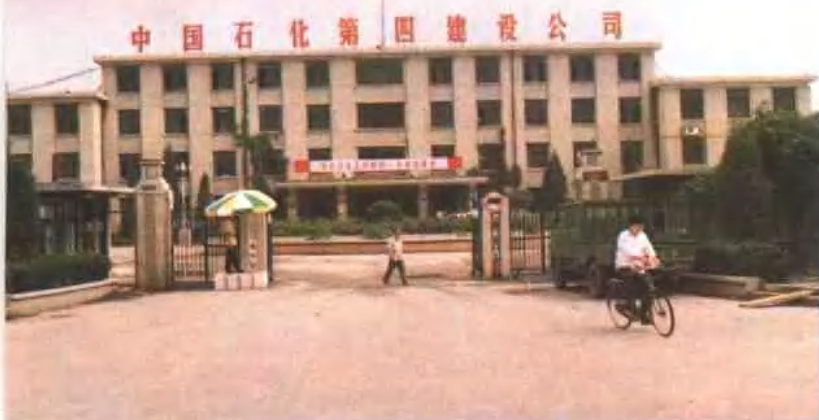
中石化四公司办公楼
