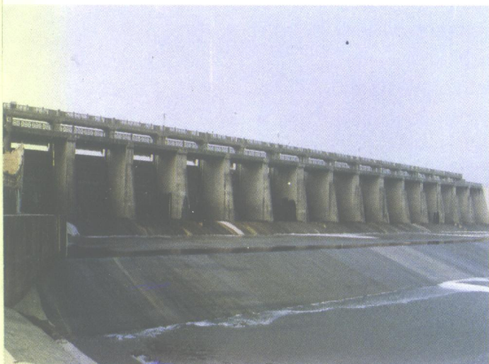
石梁河水库泄洪闸
