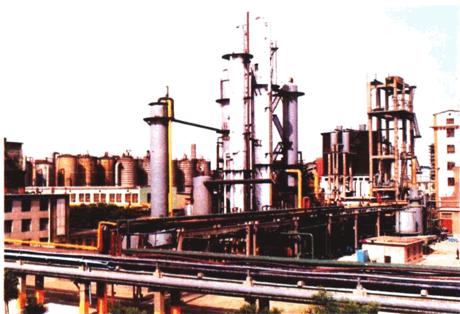
石家庄化肥厂是省石油化工厅直属大型企业,年产合成氨 14 万吨,主要产品为尿素、硝酸铵、硝酸钠、纯碱 (省石化厅供稿)
