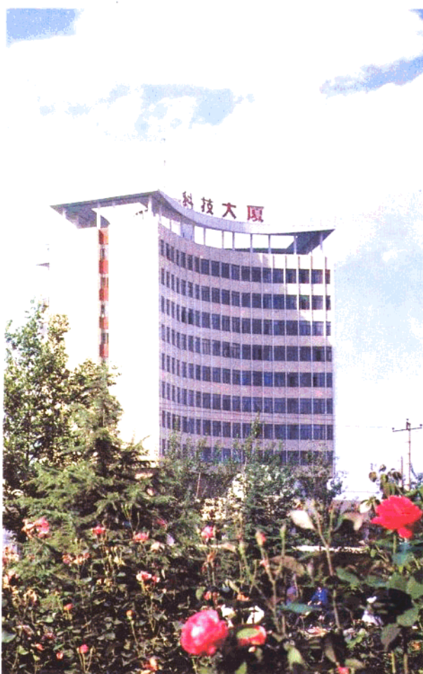
河北省科技开发服务中心大楼外景
