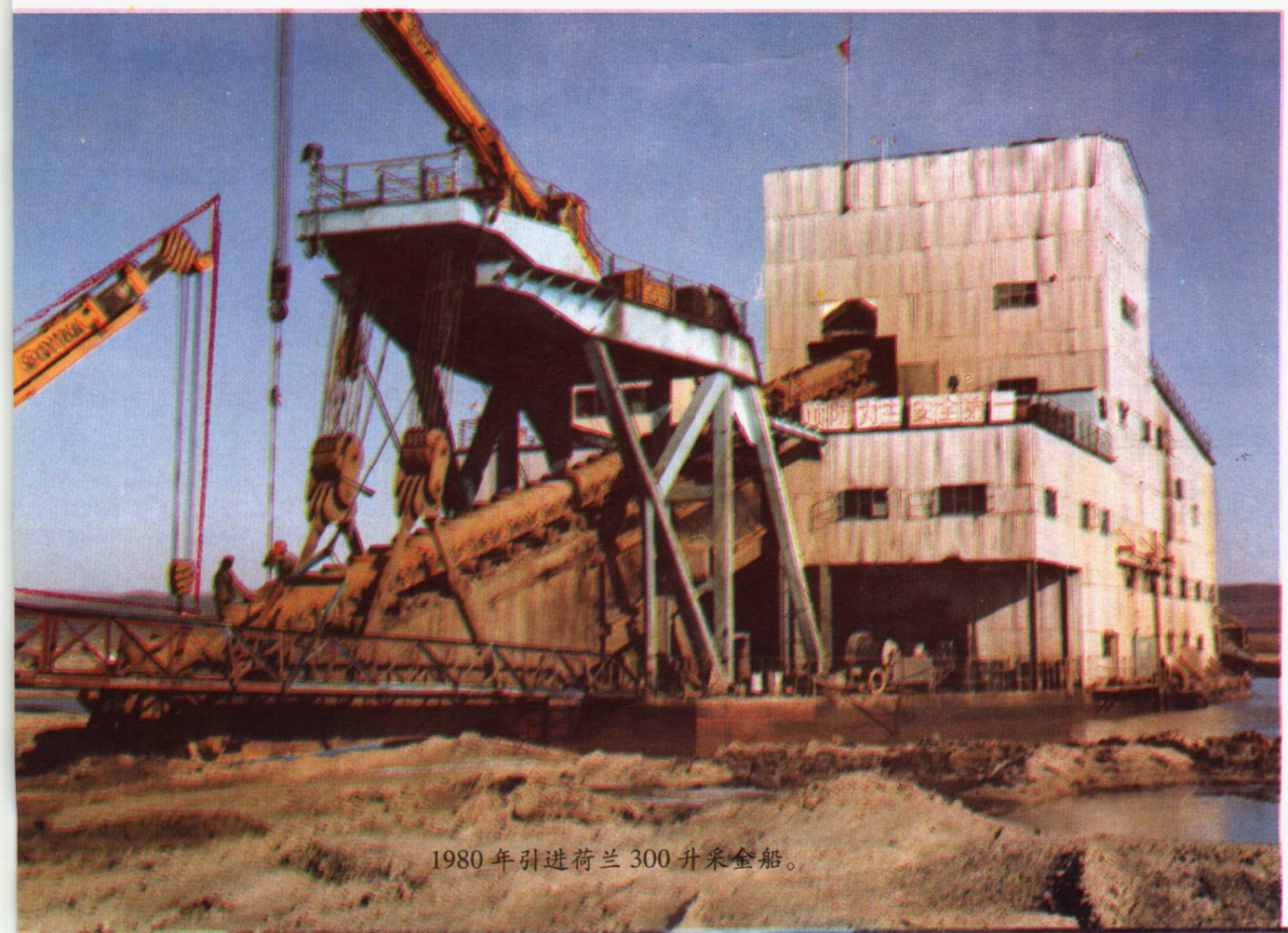
黑河金矿局五道沟金矿 150 升 HC 型采金船在工作。
