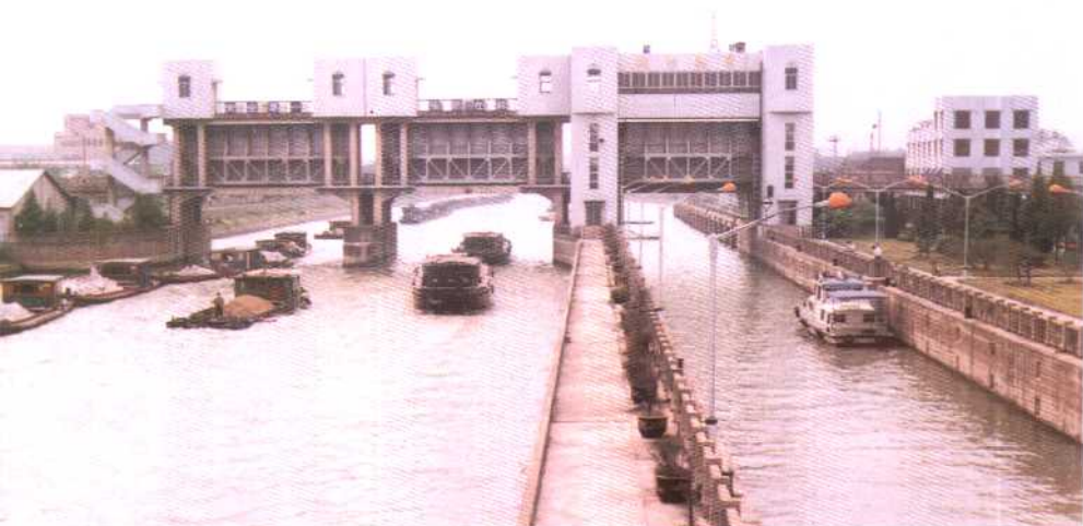
◇京杭运河长湖申线湖州市河改线工程的湖州船闸
