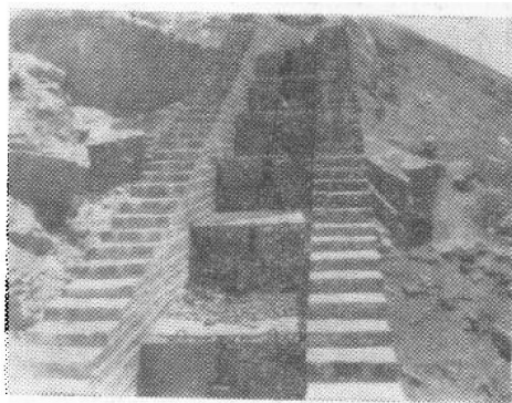
图 1-4 阶梯卧管式涵洞进口
