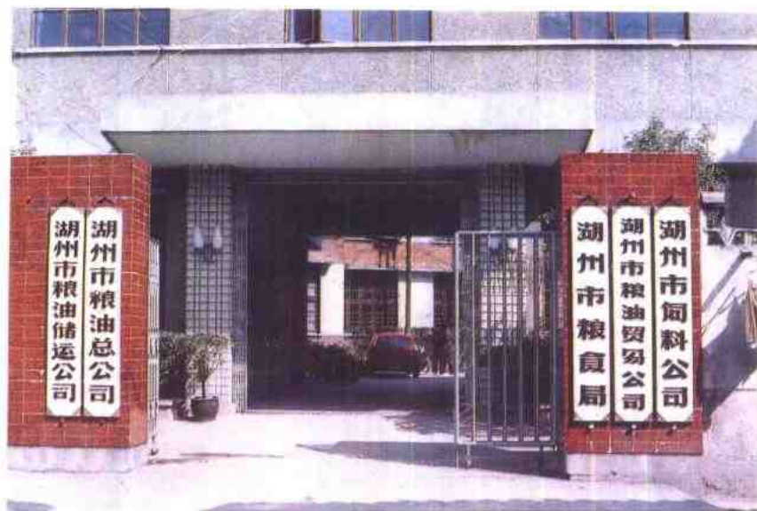
湖州市粮食局办公楼
