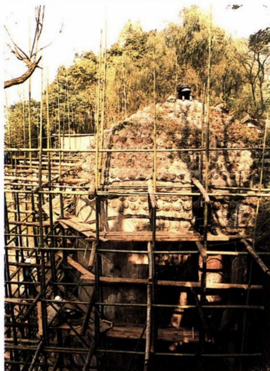
图2-17 对乐山大佛头部进行无损检测
