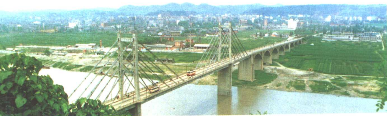
三台涪江大桥
