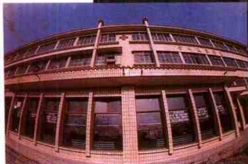
◁ 新建的天宁医院门诊大楼
