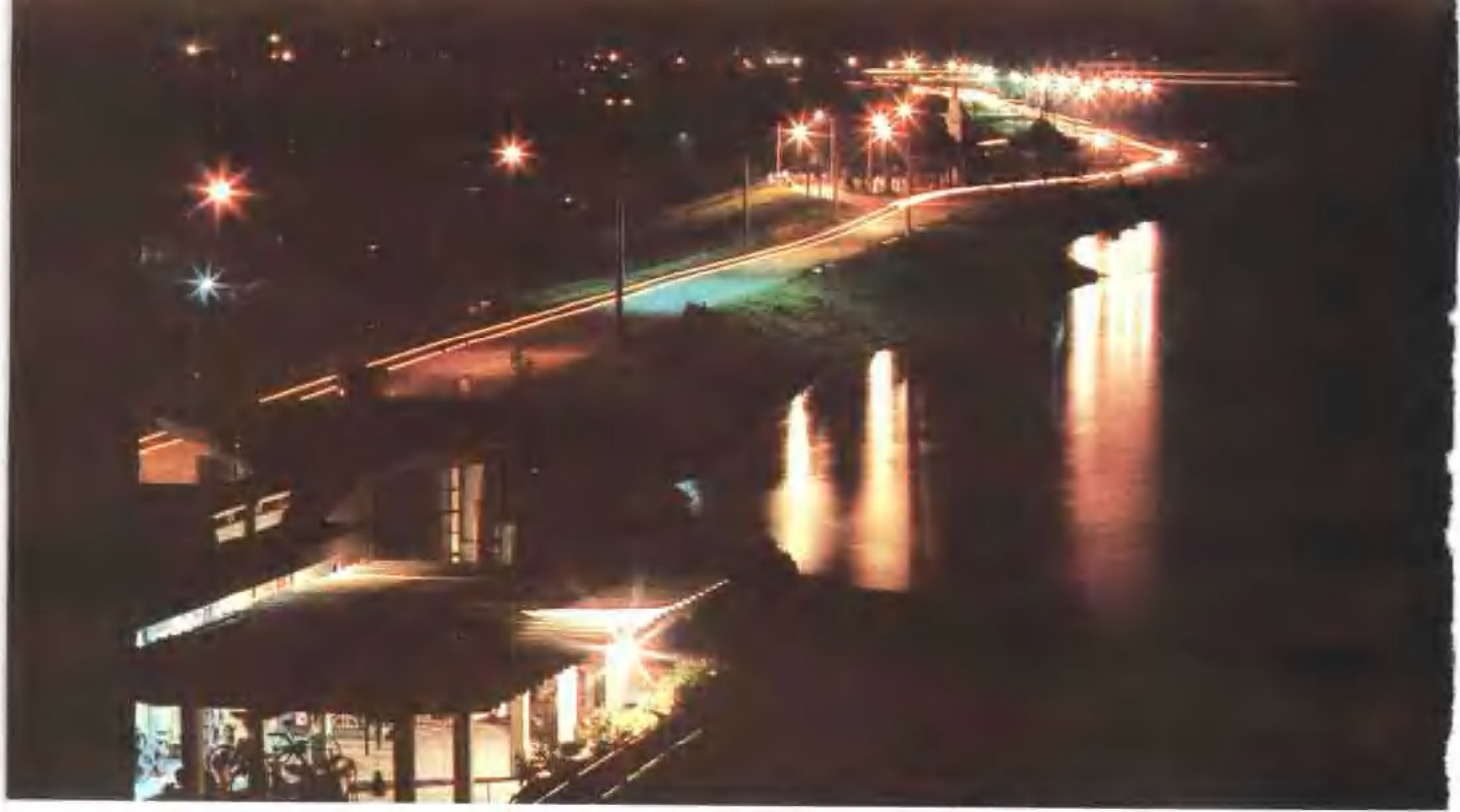
△汛期，处在高度戒备下的荆江大堤
