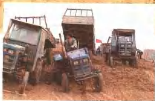
△荆江大堤堤身加固工程 吴森泉摄
