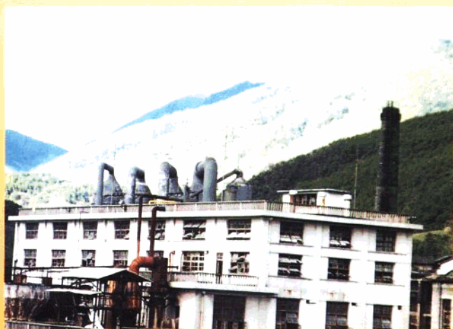
乔后盐矿真空制盐车间
