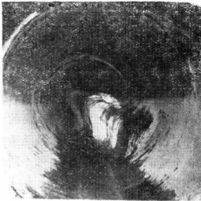
照片 1 绿水河压力水道埋管失稳 (自桩号 0+922.5 米向上游方向拍摄)
