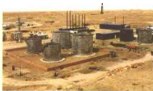
格尔木100万吨炼油厂现已完成二期工程建设
